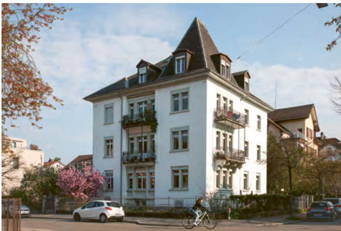
Das Liegenschaft an der Wartstrasse 66 wird seit jeher sorgfältig und liebevoll unterhalten. In den Innenräumen finden sich schöne und gut erhaltene Jugendstil-Elemente.
