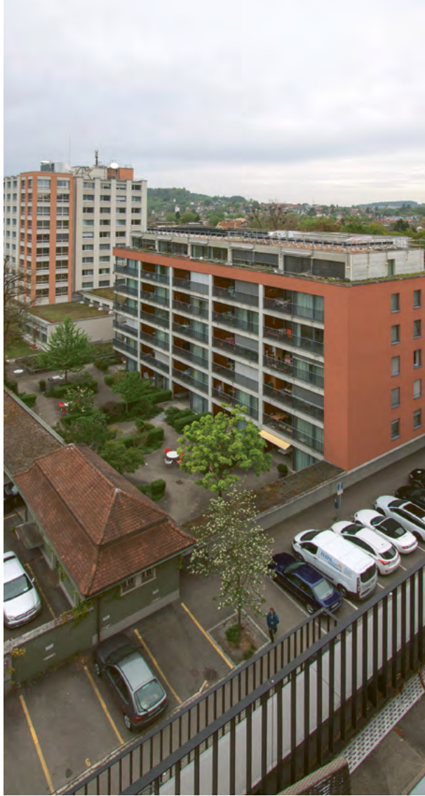
Blick auf das Wiesengrund-Areal: Das Seniorenzentrum im Hochhaus, rechts daneben die Altersresidenz Eichgut und links im Haus mit den grünen Aussenwänden das Jugendprojekt «Trampolin».
